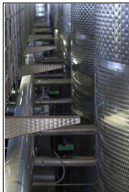
Figura 2 Particolare dei tini e delle valvole termostatiche
