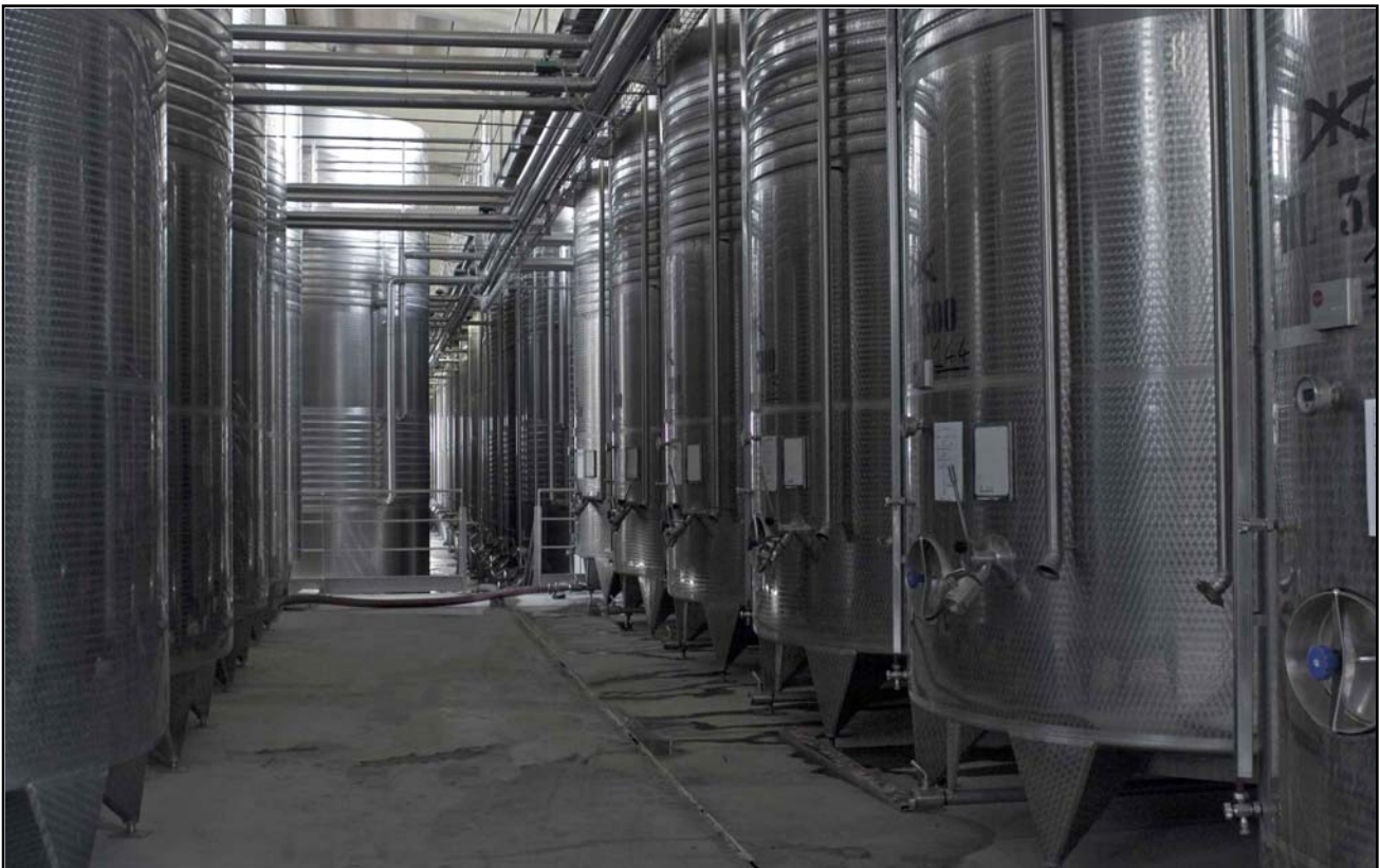
Figura 4 interno della cantina
