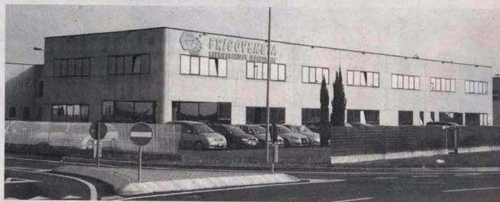
UN'UNICA SUPERFICIE DI 56 MILA MQ - Questo l'ampliamento di Frigoveneta in programma. I 5.000 mq di suolo pubblico venduti dal Comune permetteranno di collegare il nuovo lotto con le strutture già esistenti
